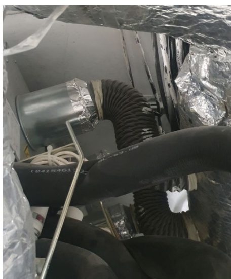
Vue d'une arrivée d'air sur la MTA
