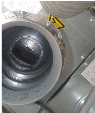
Régulateur 40m³/h placé dans le flux d'air neuf en entrée de MTA
