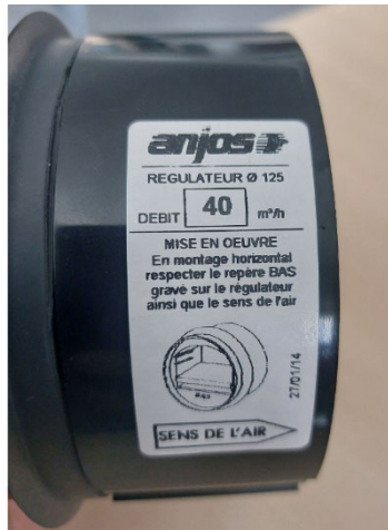
Régulateur 40m³/h placé dans le flux d'air neuf en entrée de MTA
